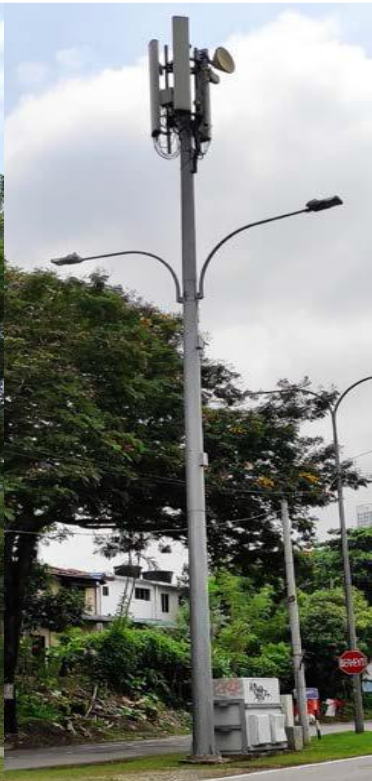
Jenis Struktur Pemancar Komunikasi Pelbagai Fungsi (Smart Pole,Lampu Limpah dan Lampu Jalan)
