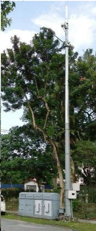
Jenis Struktur Pemancar Komunikasi Pelbagai Fungsi (Smart Pole,Lampu Limpah dan Lampu Jalan)
