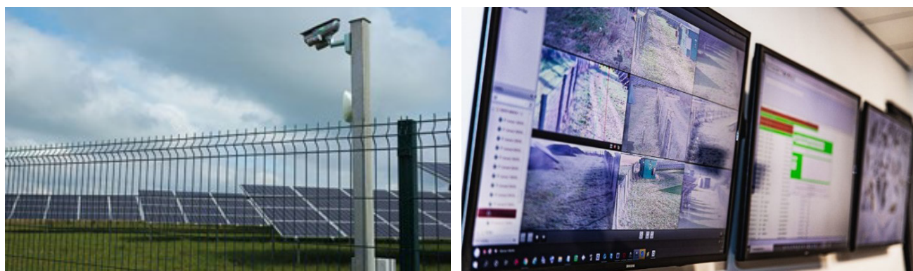
Foto 13: Komponen keselamatan bagi pembangunan ladang solar
