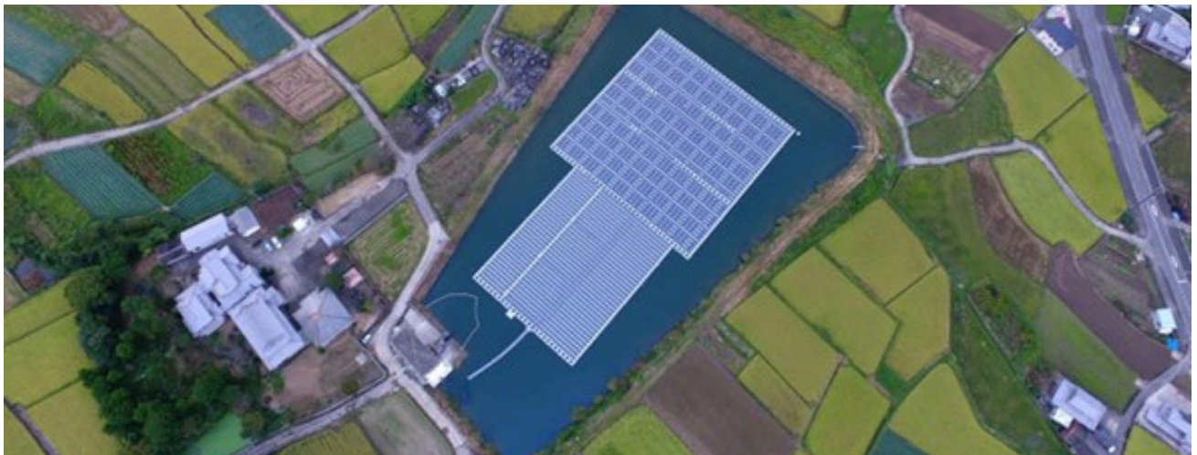
Foto 5: Pembangunan ladang solar atas permukaan air
