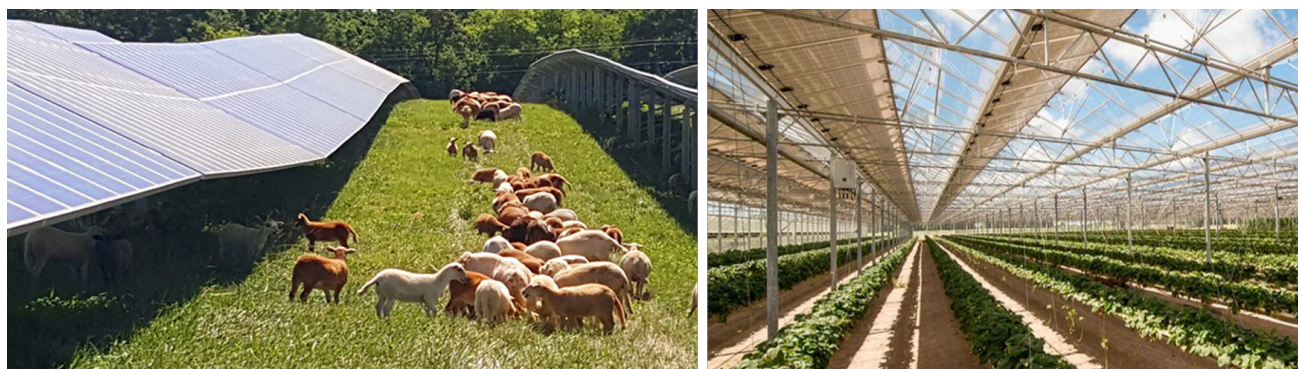
Foto 12: Contoh pembangunan ladang solar integrasi melalui konsep agro-photovoltaic
