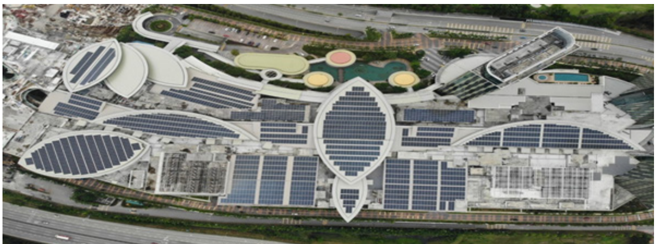
Foto 24: Panel solar yang diintegrasikan dengan bangunan melibatkan bahagian bumbung ( roof mounted )
