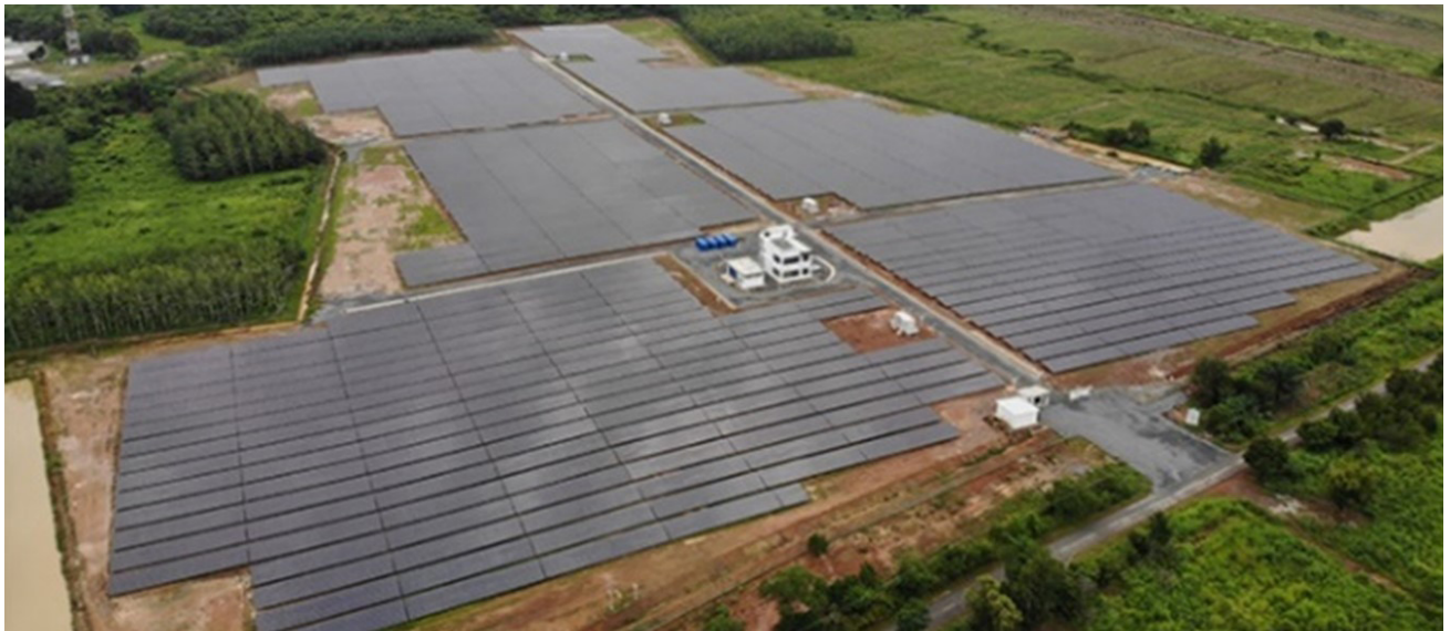
Foto 4: Pembangunan ladang solar atas tanah
