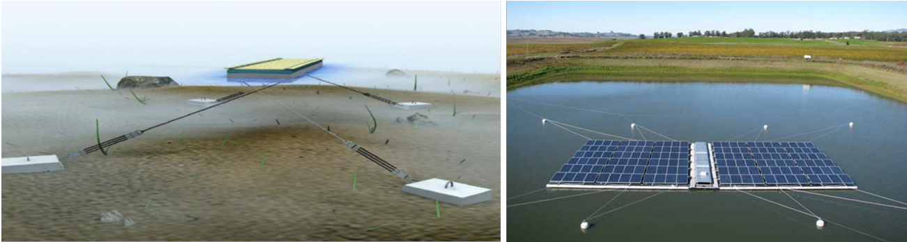
Foto 11: Gambaran sistem bottom anchoring (kiri) dan gambar sebenar sistem bank anchoring (kanan)
