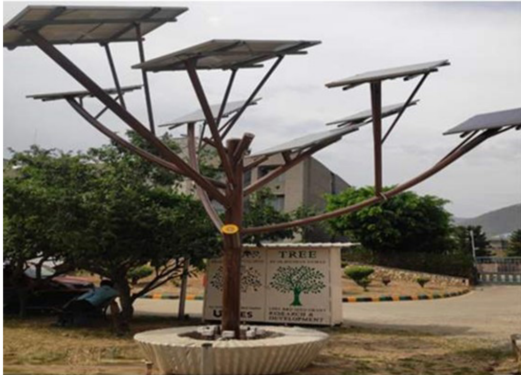
Foto 32: Pokok solar yang menyimpan tenaga untuk mengecas peranti
