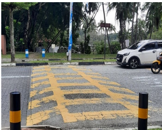
Foto 11 : Contoh penyediaan traffic calming seperti bonggol dan corrugated road ke kawasan lapang
