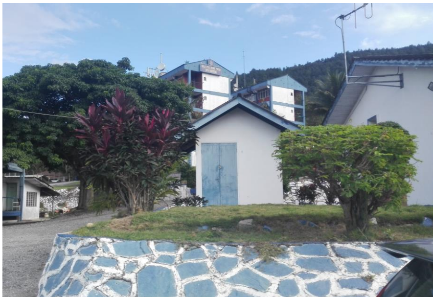
Foto 2.41: Keadaan semasa pembangunan di sekitar Kg. Bukit Tinggi yang tidak terjejas akibat gegaran gempa bumi yang lemah
