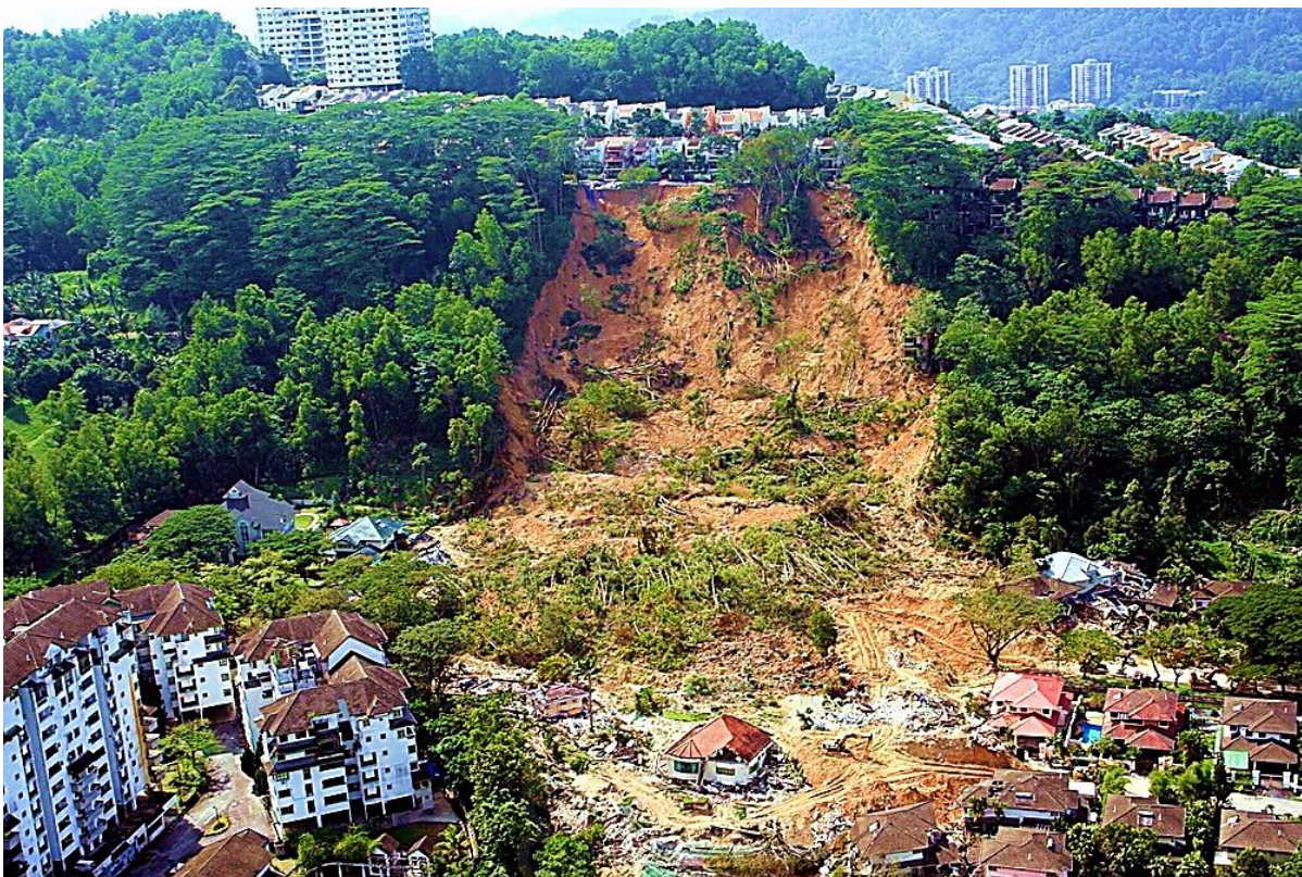
Foto 2.13: Tragedi tanah runtuh di Bukit Antarabangsa, Hulu Klang pada tahun 2008
