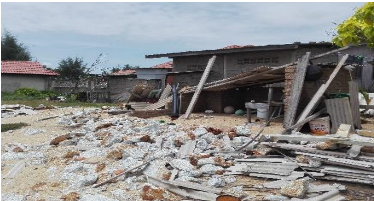
Foto 2.24: Rumah yang pernah dinaiki air akibat kejadian air pasang
