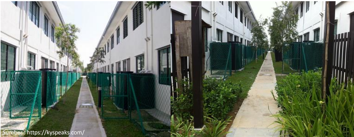
992 SPAH dipasang di 496 unit rumah Ken Rimba, Seksyen 16 Shah Alam
