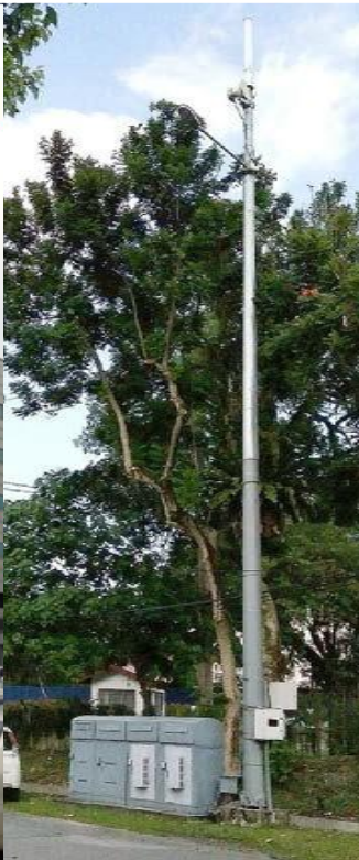
Jenis Struktur Pemancar Komunikasi Pelbagai Fungsi (Smart Pole,Lampu Limpah dan Lampu Jalan)
