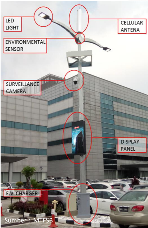
Jenis Struktur Pemancar Komunikasi Pelbagai Fungsi (Smart Pole,Lampu Limpah dan Lampu Jalan)
