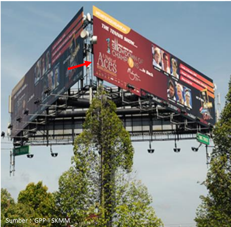
Struktur papan iklan (billboard) yang diintegrasikan dengan sistem komunikasi
