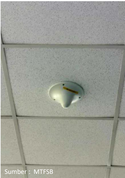
Antena Sistem IBC
