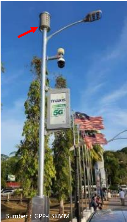
Tiang lampu jalan diintegrasikan dengan sistem komunikasi
