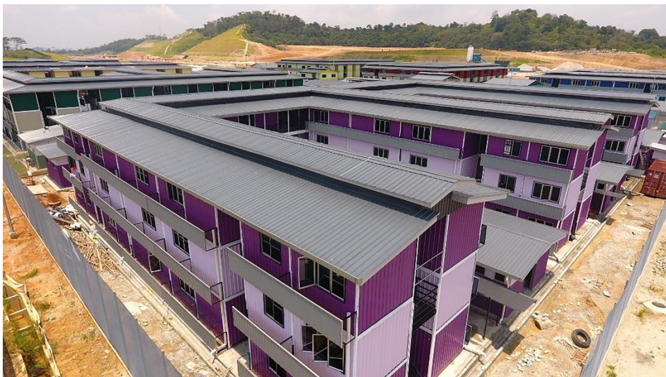
Foto 4 : Contoh Pembangunan CLQ MRT Sungai Buloh, Selangor
