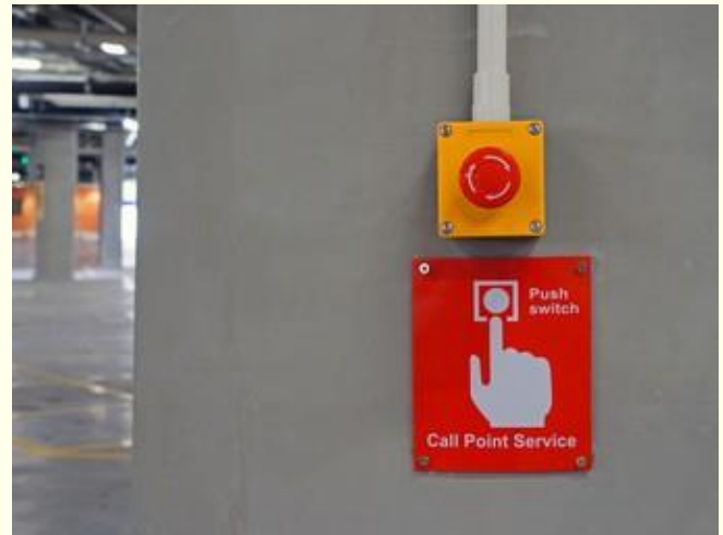
Gambar 18: Penggunaan simbol yang jelas dan warna yang terang pada butang kecemasan
