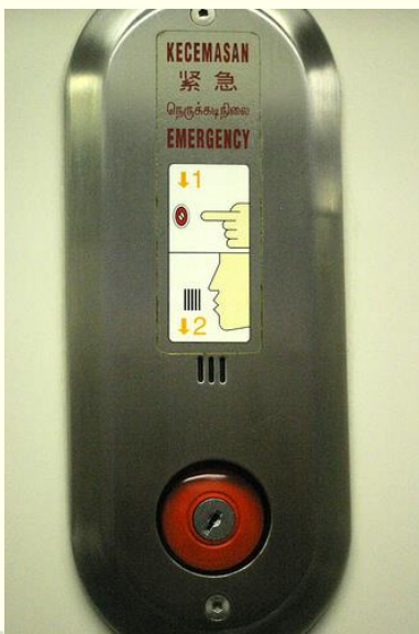
Gambar 17 : Contoh butang kecemasan yang dilengkapi interkom dan panduan penggunaan bergambar memudahkan pemahaman inividu autisme
