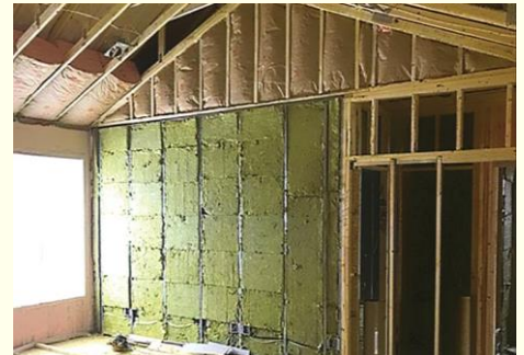
Gambar 12: Terdapat juga kaedah untuk menanam bahan semulajadi mampat dalam dinding bagi mengurangkan kesan bunyi.
