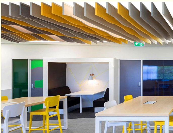
Gambar 13 : Pemasangan selang lapis bagi siling yang tinggi dapat mengurangkan bunyi.
